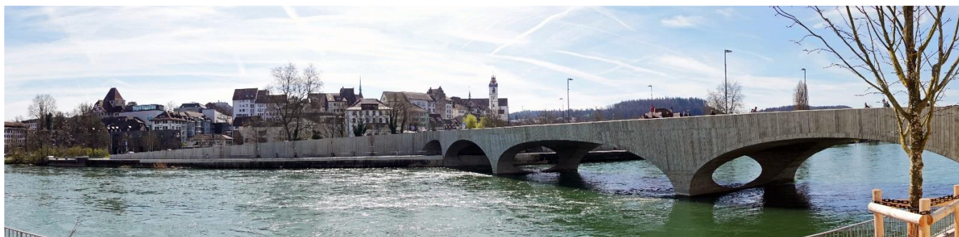
Neue Aarebrücke, architektonisches Juwel.
